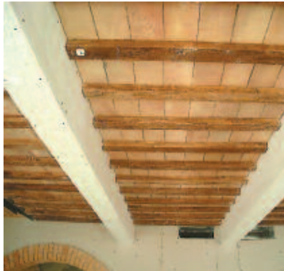
6 - tamponamento di base realizzato al grezzo mediante l'inserimento di fasce di lunghezza costante
