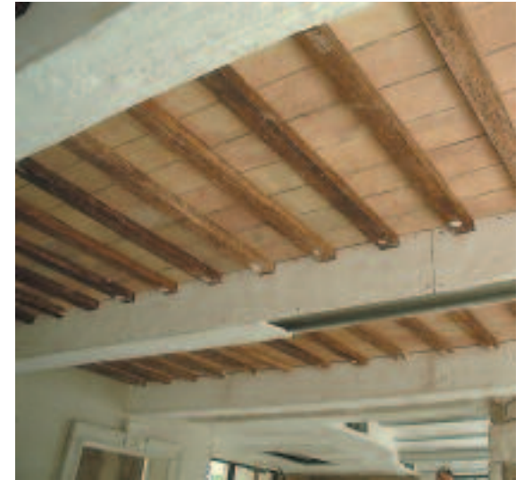
4 - particolare di montaggio delle travi principali
