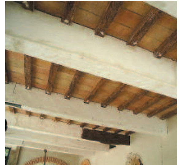
Particolare della stuccatura delle fasce
