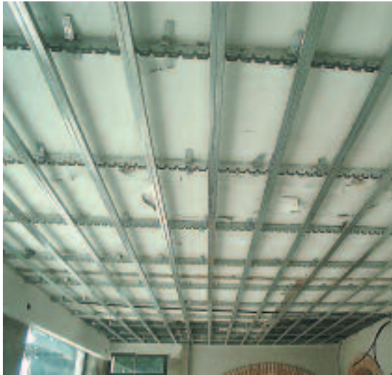
1 - fissaggio intelaiatura con profili metallici
