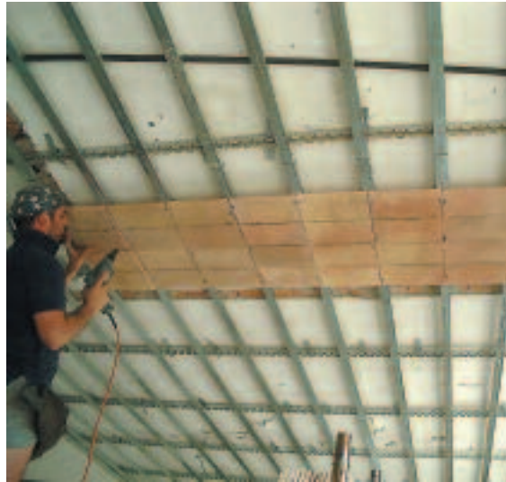
2 - fissaggio meccanico delle pannelle con viti autofilettanti
