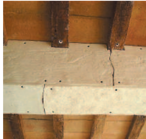
Primo piano di una trave montata - grezza
