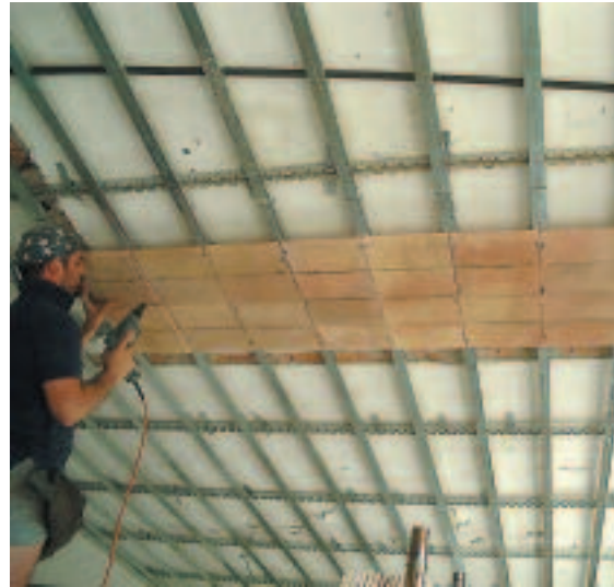
2 - fissaggio meccanico delle piastrelle con viti autofilettanti
