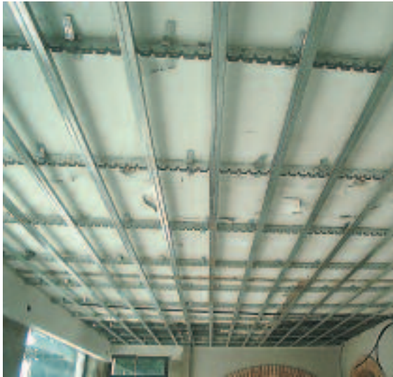
1 - fissaggio intelaiatura con profili metallici
