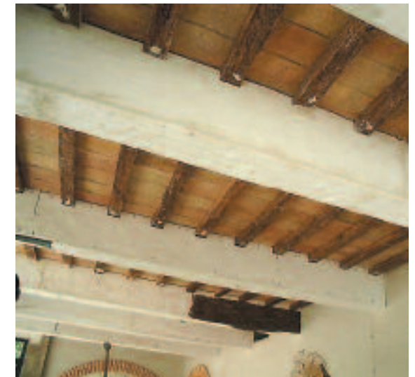
Particolare della stuccatura delle fasce
