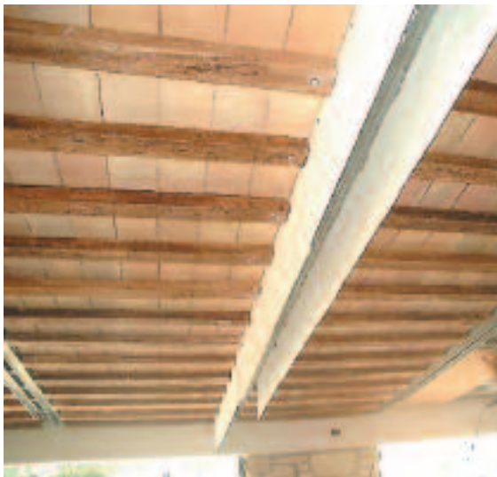
5 - montaggio delle travi composte da fasce con particolare dell'accostamento delle fasce laterali delle travi
