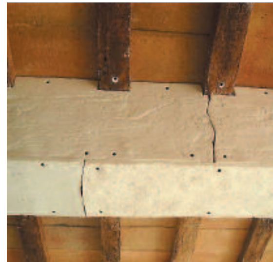
Primo piano di una trave montata - grezza
