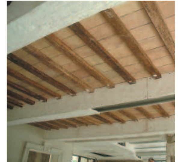
4 - particolare di montaggio delle travi principali
